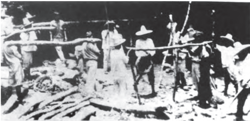
Construcción del acceso a la zona de riego con la participación de alumnos y campesinos de la comunidad de Cerro Hueco, Chiapas, 1931. Fuente: Hernández, 2004, p. 196.
