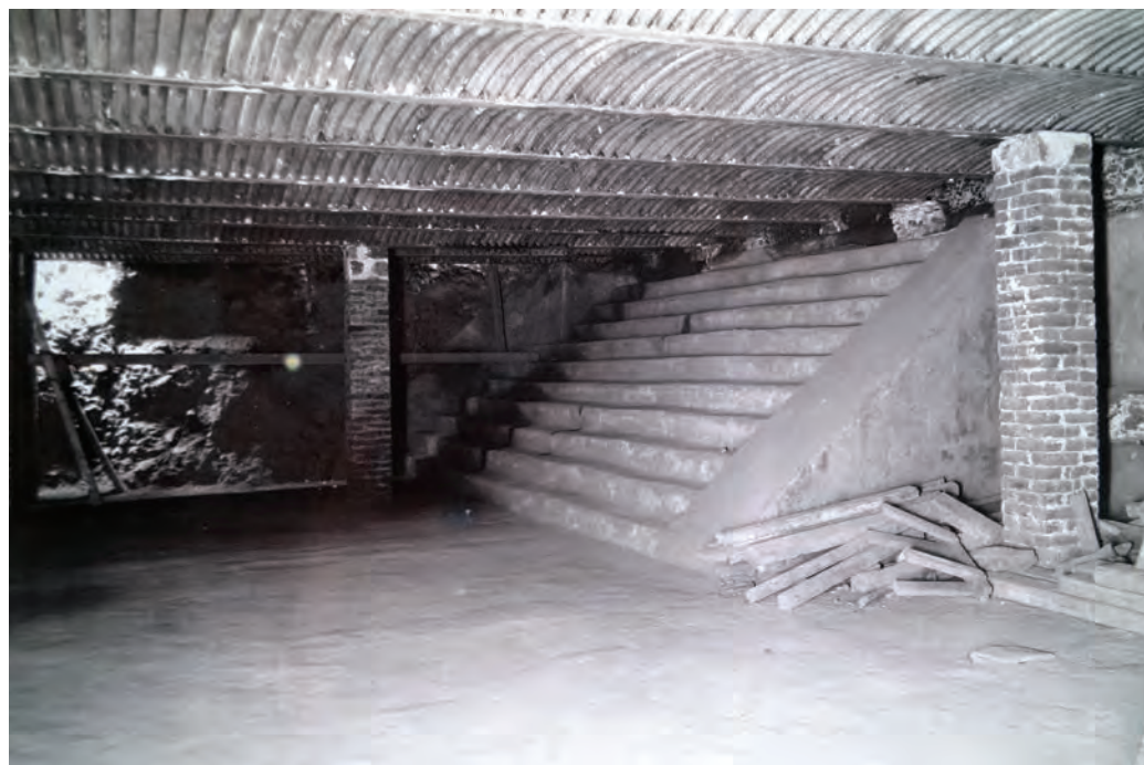
Vista de los subterráneos, techados durante los trabajos de exploración. Fotografía cortesía Fundación Acervo Leopoldo Batres.
